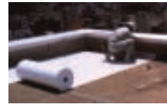
② 絶縁用シート敷設
