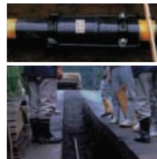
図6 ゴム輪形ロング片受け直管の施工例
