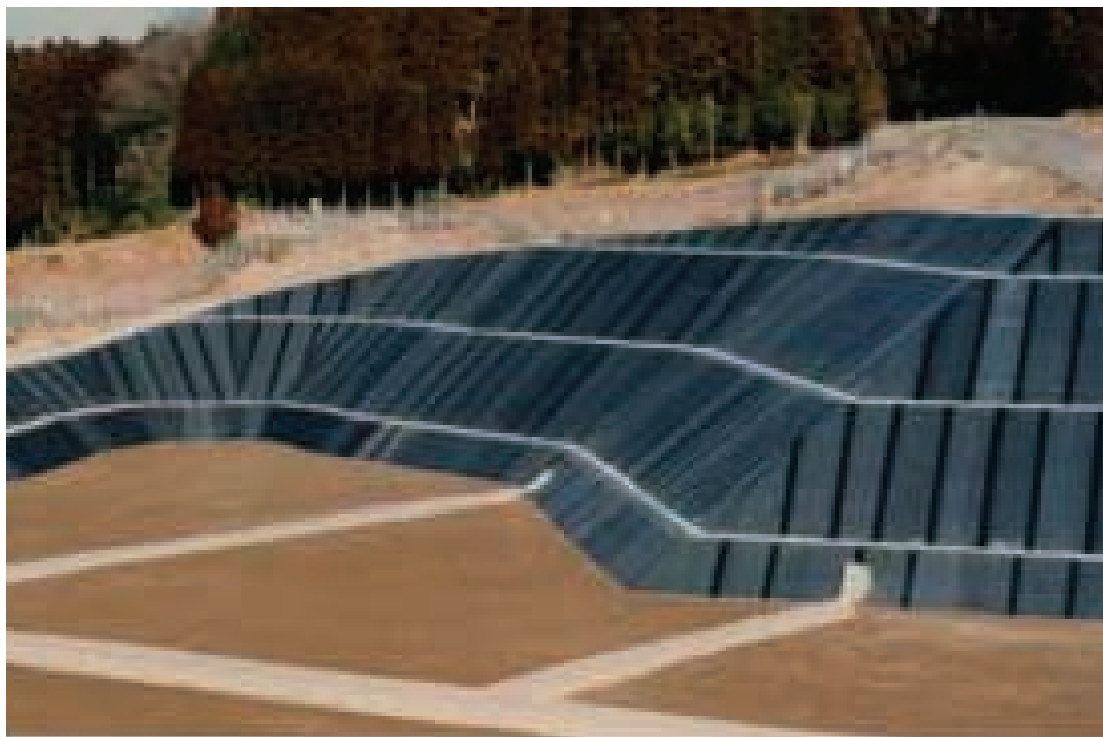
(宮崎県内最終処分場、太い線はシート接合場所)
