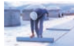
④ 防水シートの敷設
