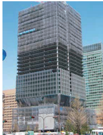
図 17. 工事用シートが利用された工事現場の例 出典：(公財) 日本防災協会資料より
