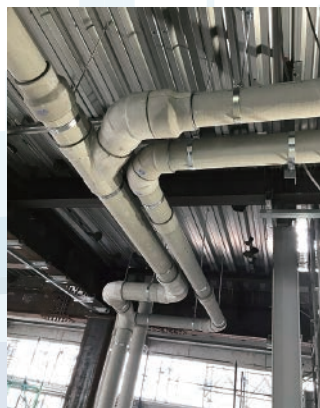
図 11. 耐火二層管の例
