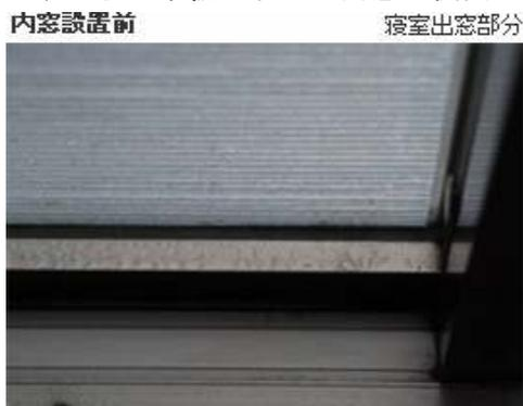
サッシ部分に水がたまり断熱フィルム上も結露している。
