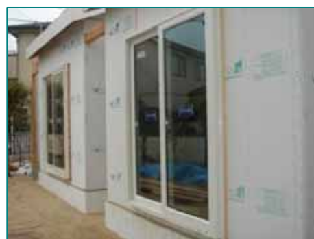
施工中の試験棟(2棟)
