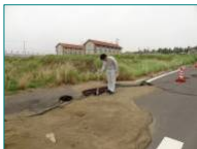
(写真 1 - 液状化：噴砂)
