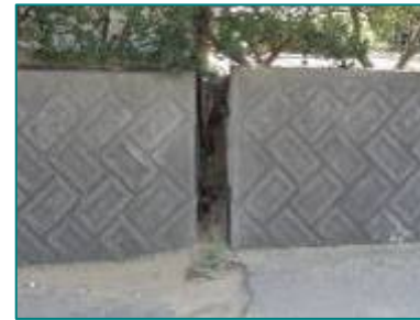
(写真 3 - 地割れによる壁の開口)
