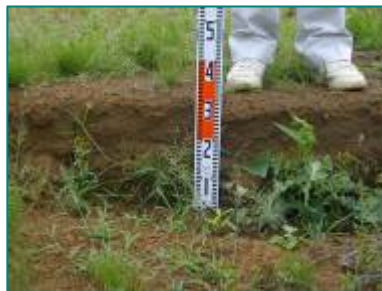
(写真 2 - 地盤沈下)
