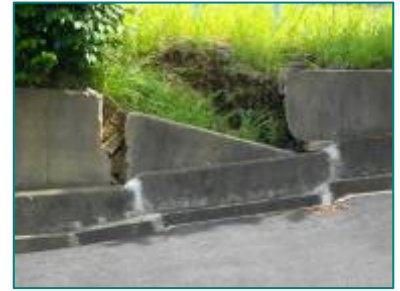
(写真6—地割れによる壁の崩壊)
