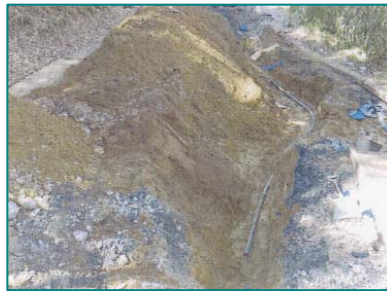
(写真5—道路の崩落)
