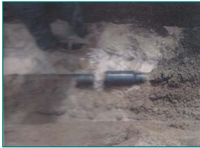
(写真4—管路被害：管の抜け)
