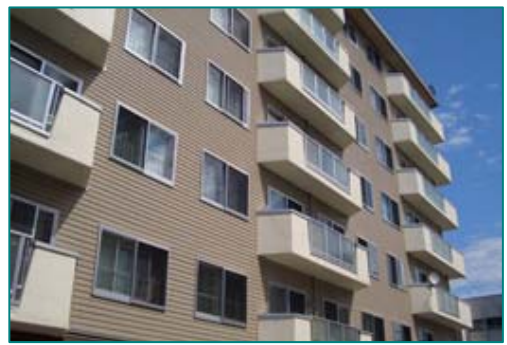
北海道マンション施工例
