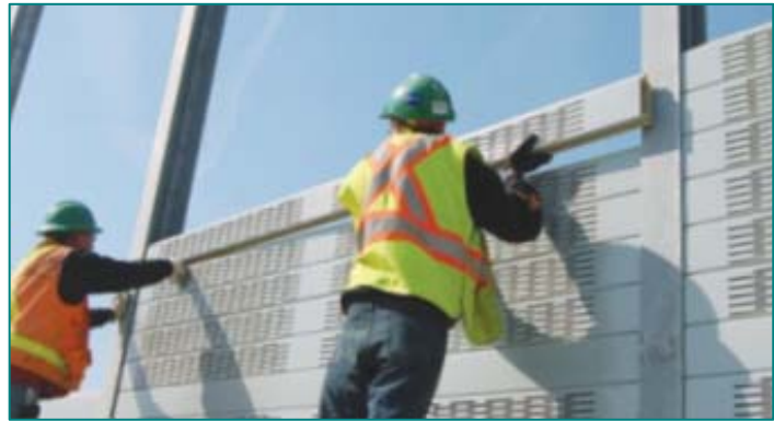
塩ビ製板の構造と防音壁施工状況
