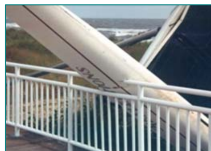
塩ビ製手すりの施工例 (VI HP より)
