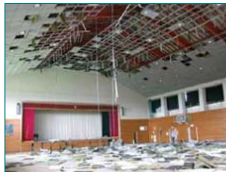
東日本大震災により落下した 体育館の天井
