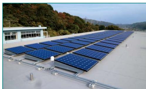
写真3.学校屋上への太陽光発電の設置例
