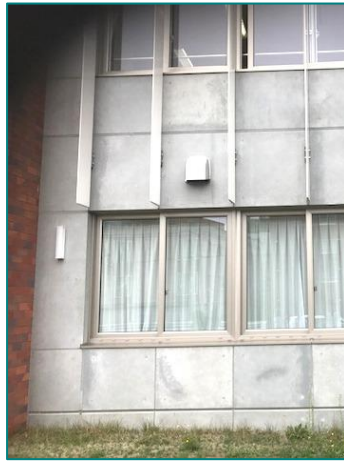
学校への施工
