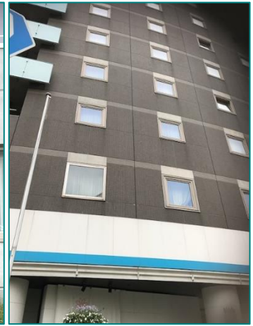
ホテルへの施工
