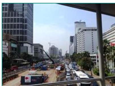
インドネシア高速鉄道建設中
