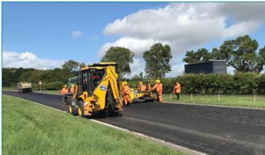
写真：MacRebur 社のプラスチックゴミ活用アスファルト舗装（同社 HP より）
