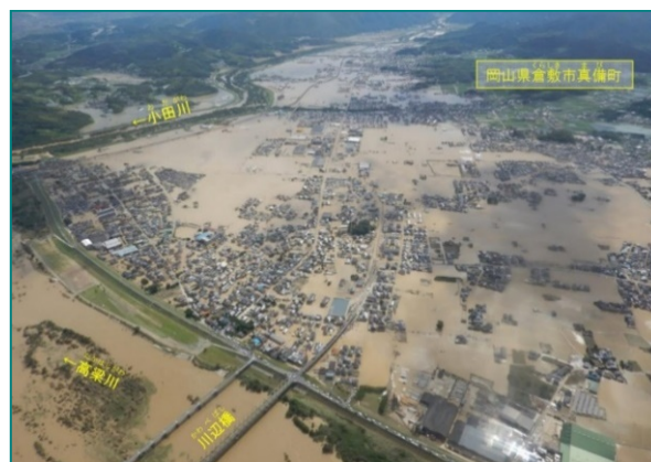
2018年西日本豪雨 大きな被害が出た岡山県倉敷市真備町 (出典：中国地方整備局)
