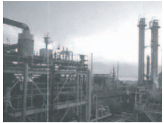
鐘淵化学高砂工業所（兵庫県高砂市）
