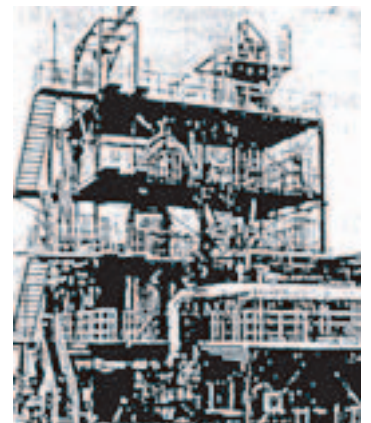
ガス化溶解プラント
