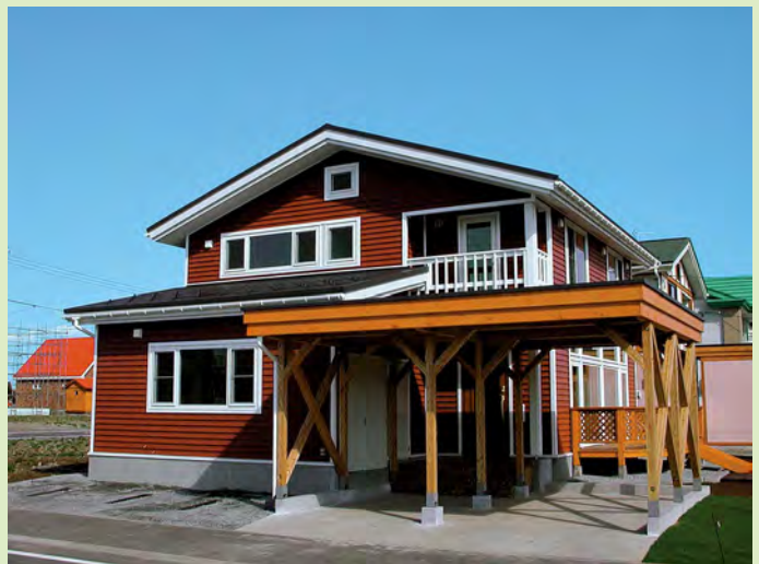
塩ビサイディングの外壁
