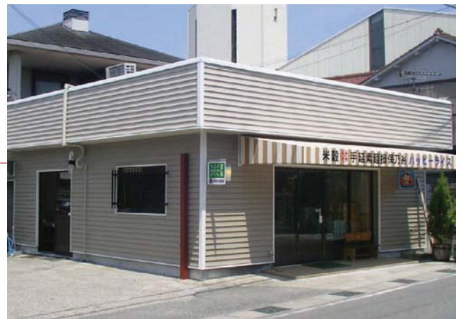
店舗のリフォーム (窯業系外装材の上に施工)
