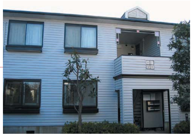
アパートのリフォーム (窯業系外装材の上に施工)
