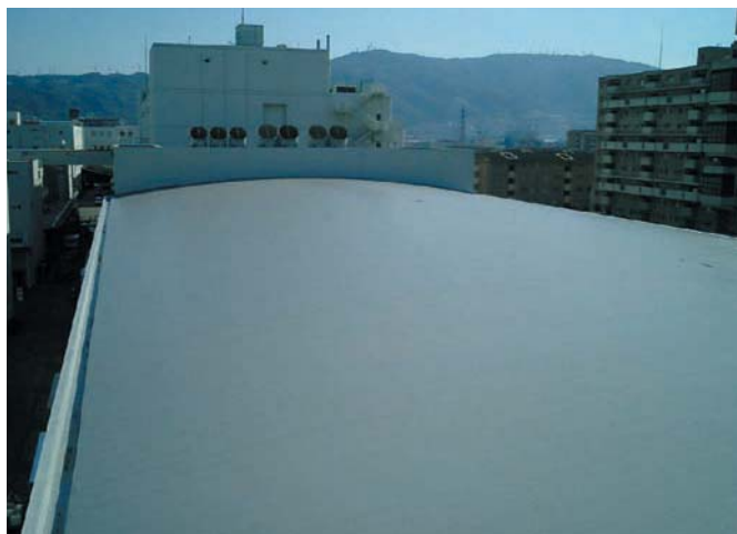
屋上防水シート
