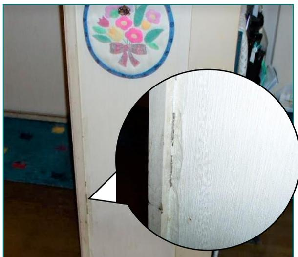
室内中央の柱には羽アリが飛び立った穴が
