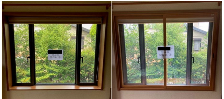
わかりにくいですが、「施工前」と「施工後」の写真です
