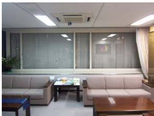
樹脂製内窓施工後の内観写真(本部棟内)
