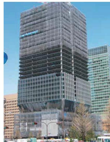
図 17. 工事用シートが利用された工事現場の例
