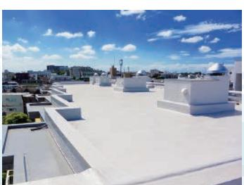
図 14. 塩ビシート防水の例
