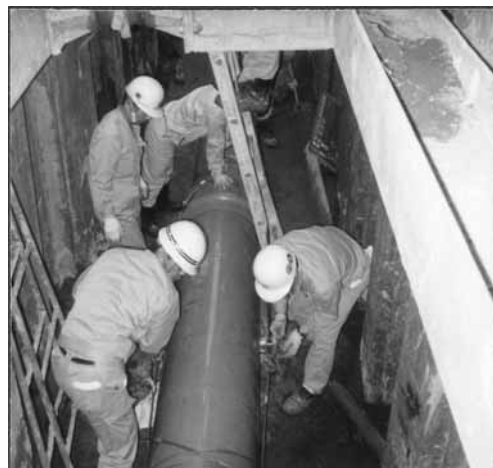
道路下埋設実験
