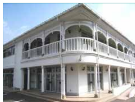
建物全体に塩ビサイディングが施工された“やまびこ会館” (クリックで拡大)
