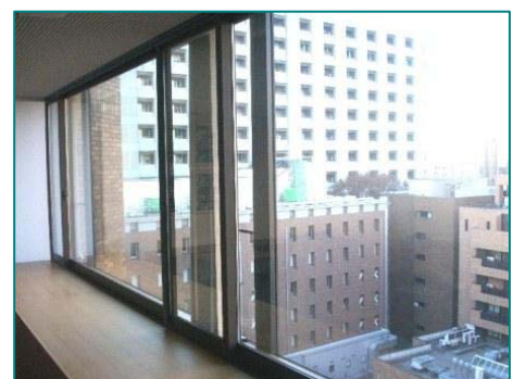
東京大学本部棟・内窓設置後
