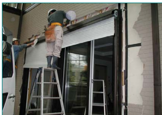
住宅解体に伴う塩ビサッシの回収
