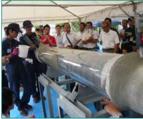
③ SPR 工法
