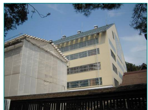
出雲大社 (上：遷宮前 / 下：工事中)
