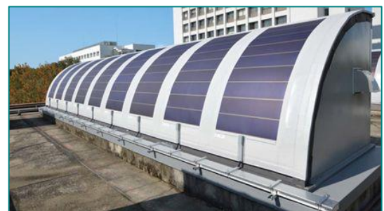
塩ビ樹脂系シート防水と一体化したアモルファスシリコン系太陽光パネル
