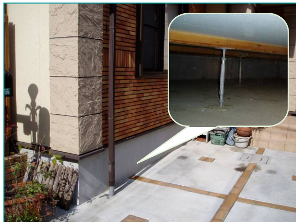
現在の住宅の基礎周りと床下
