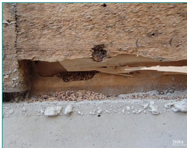
アメリカカンザイシロアリの被害があると粒状の糞が積もる
