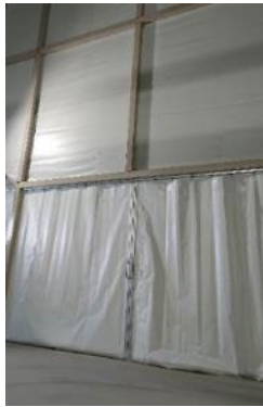
①【ワンナップ 1 類賞】 有限会社大西テント商会 工場プラントの防塵間仕切り
