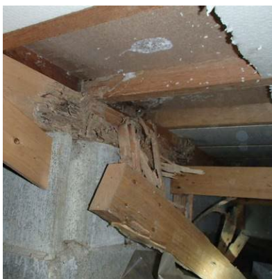
こんな床下では、大地震の前ではひと溜まりもない（写真左）、床下の束柱や大引きなどに広がるシロアリ被害（写真中央）、シロアリ被害にドライバーが簡単に刺さる（写真右）
