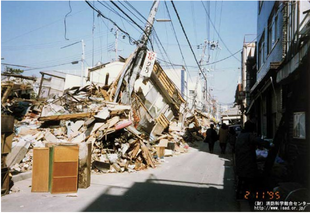
阪神・淡路大震災で全壊した建物の多くに シロアリの被害（災害写真データベースより引用）
