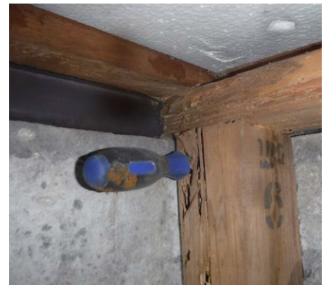
こんな床下では、大地震の前ではひと溜まりもない（写真左）、床下の束柱や大引きなどに広がるシロアリ被害（写真中央）、シロアリ被害にドライバーが簡単に刺さる（写真右）
