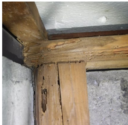
こんな床下では、大地震の前ではひと溜まりもない（写真左）、床下の束柱や大引きなどに広がるシロアリ被害（写真中央）、シロアリ被害にドライバーが簡単に刺さる（写真右）
