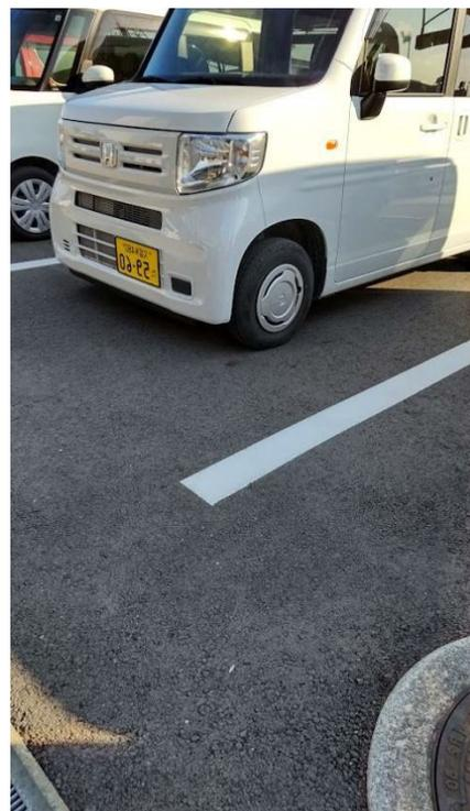
左：青点線から下が廃農ポリ使用のアスファルト道路
