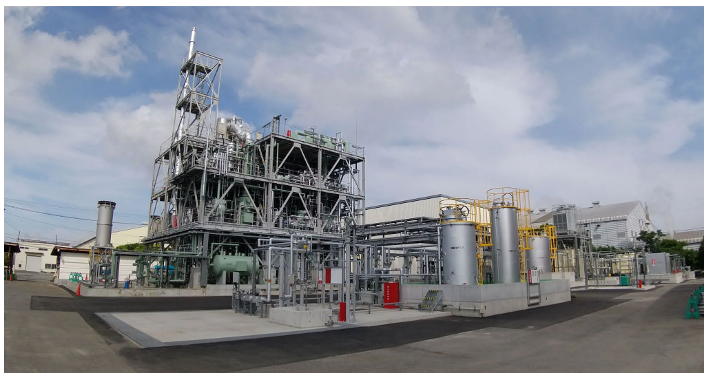
写真1 ICFG 実証プラントの外観
